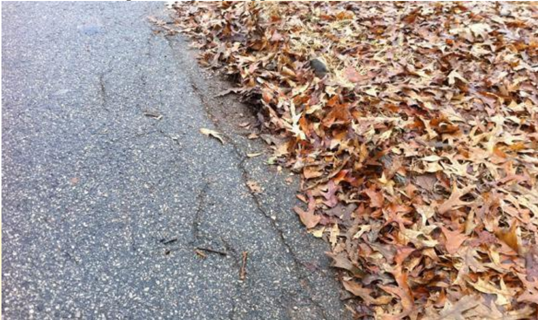
Fig. Edge Cracks
