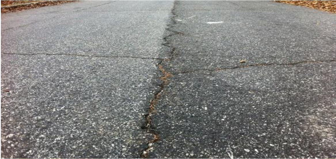
Longitudinal (Linear) Cracking
