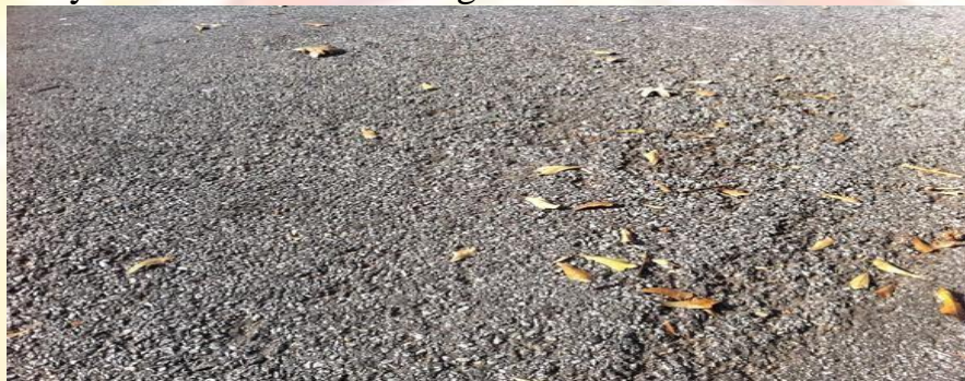
Fig. Raveling (very porous asphalt)
